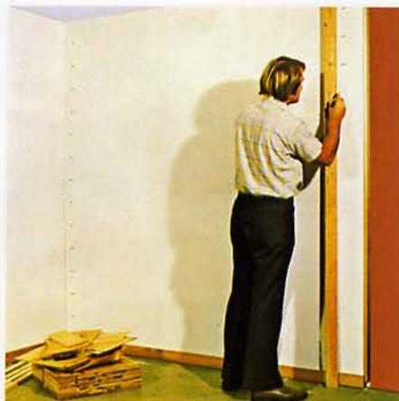
Aus der Raumhöhe und der gewünschten sichtbaren Schindelhöhe errechnen Sie die benötigte Anzahl der Querlatten und Schindeln.
