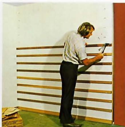
Bringen Sie die Latten im Abstand der sichtbaren Schindelgröße an der Wand an. Bei Verkleidungen übereck darauf achten, daß die Latten in der gleichen Höhe sind.
