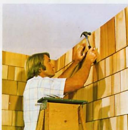
Gehen Sie Reihe für Reihe in gleicher Weise vor. Für einen bündigen Deckenabschluß sägen Sie die Schindeln der letzten Reihe passend. Die Nagelstellen der oberen Schindelreihe fallen kaum auf – man kann sie aber auch hinter einer Abschlußleiste verschwinden lassen.
