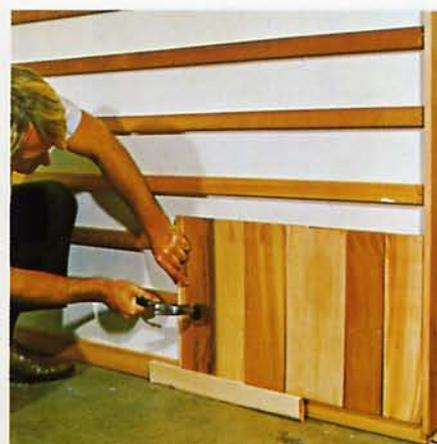
Beginnen Sie mit der untersten Reihe, die doppelt verlegt wird. Befestigen Sie jede Schindel mit zwei Nägeln, die in die Lattenmitte mit je 3 cm Abstand vom Schindelrand eingeschlagen werden.
